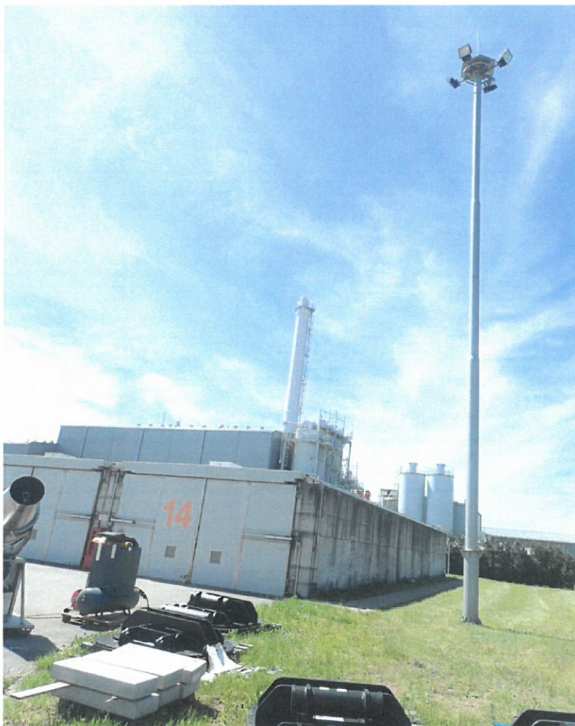
Obiekt 70.01 – Wjazd do boksu nr 14, druga kamera na maszcie latarni do monitorowania wnętrza boksu po złożeniu dachu (K20_7001, K21_7001)
