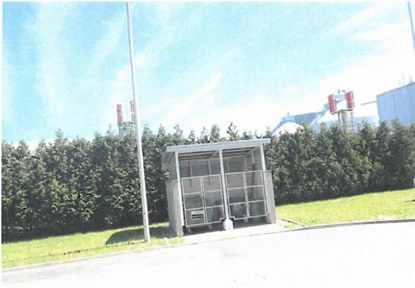
S10 – wiata magazynowa odpadów dojazd, obszar wokół wiaty (K18_S10)
