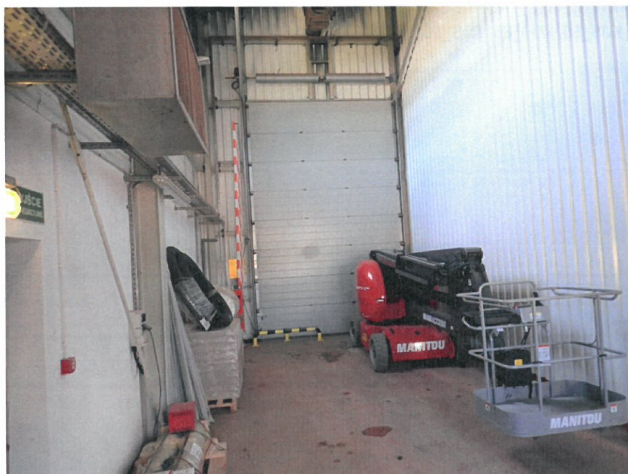
Obiekt S2 – śluza wjazdowa silos piasku (K14_S2)
