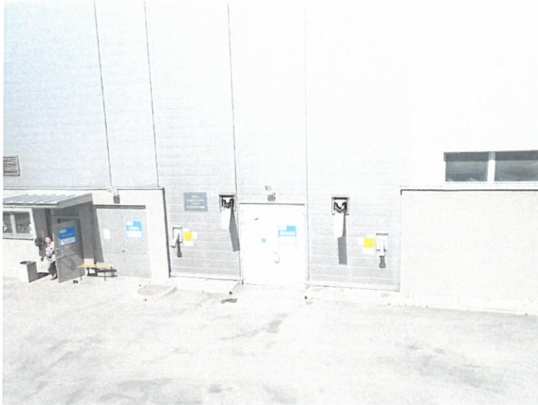
Obiekt S1 – punkt przyjęcia i rozładunku osadu wysuszonego (K19_S1)
