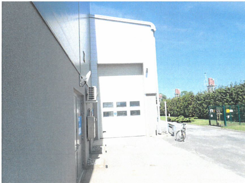
S2 – brama wjazdowa – zbiornik na tłuszcz (K15_S2)
